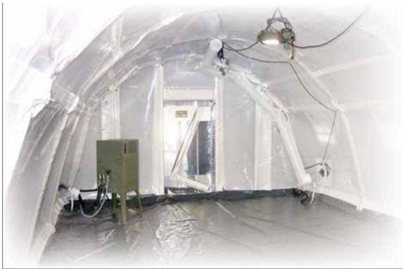
HTN sátor, levegőelosztó csatornákkal, világítással és légkondicionálással
