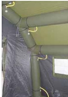
A pneumatikus rendszer főbb elemei, belülről
