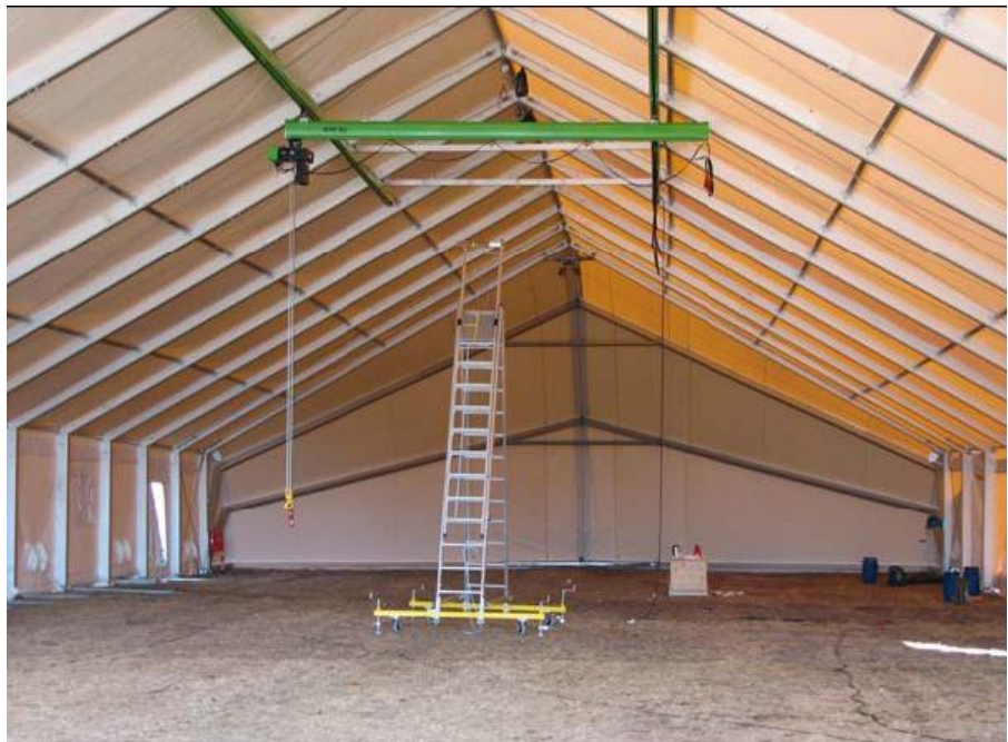
Hangár-sátor belső nézete, max. 600 kg-ig terhelhető beépített daruszerkezettel (futómacskával)
