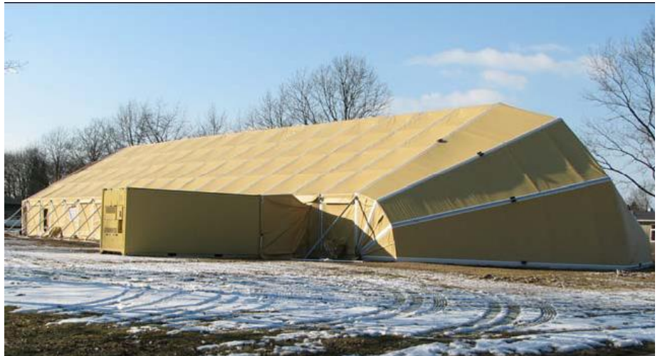
Hangár-sátor légi járművek számára, hozzacsatlakoztatott konténerrel és elektromos mozgatású oromzattal
